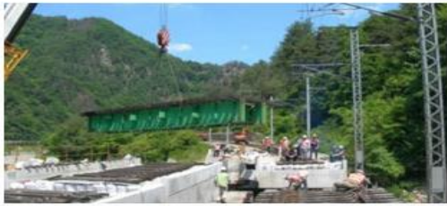
③ 既存鉄桁橋を撤去
