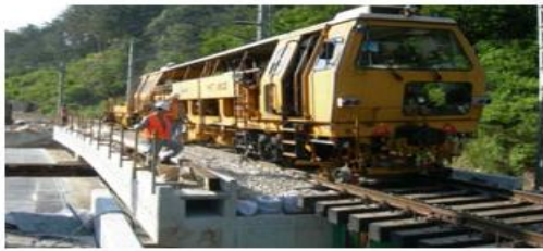
⑤ 軌道敷設及び安定化
