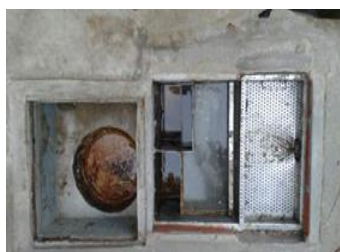
ベトナムブンタウ地域の地価埋立型下水オイル分離装置
