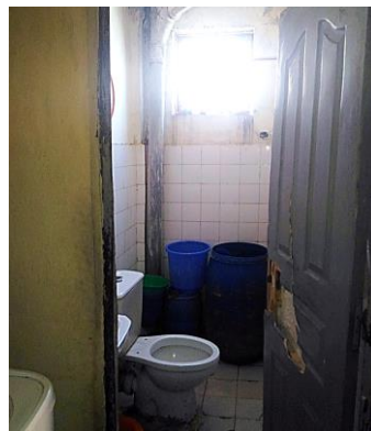
トイレ・浴室(シャワー室)
