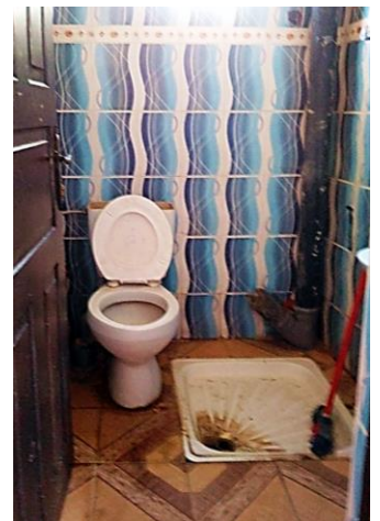
トイレ・浴室(シャワー室)
