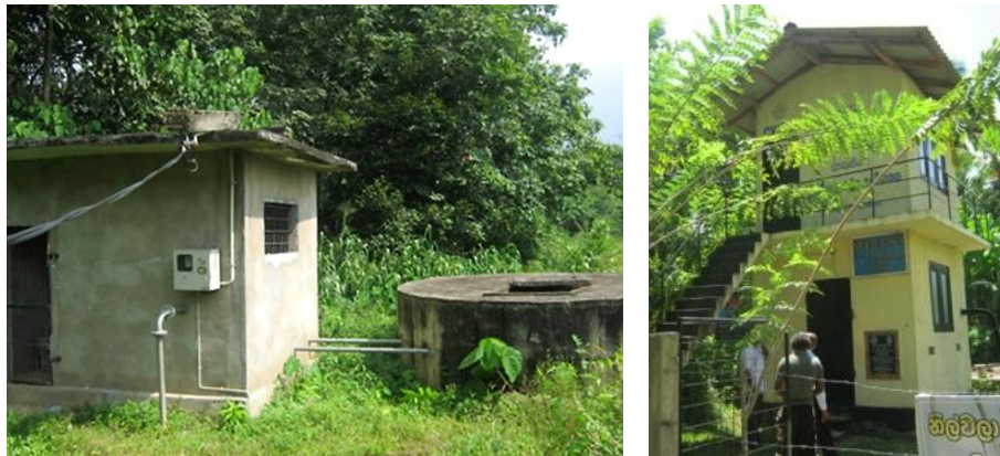
コロombo郊外・ジャルタラ地域のコミュニティ給水システム 井戸とポンプハウス(左) 高架水槽(右)
