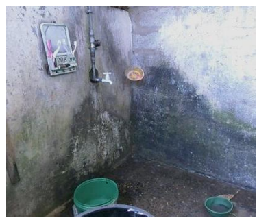
風呂場・洗濯場
