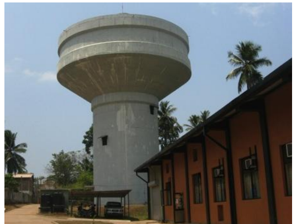
スリランカ上下水道庁のコロンボ郊外の高架配水池
