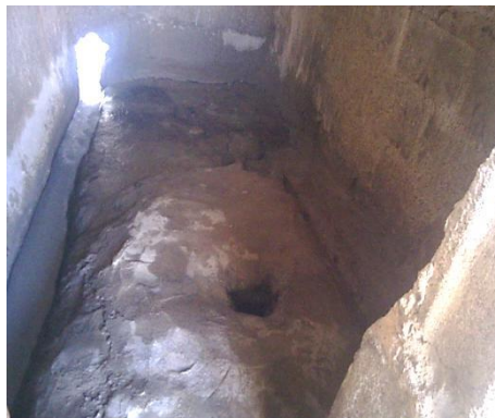
掘穴式のトイレ
