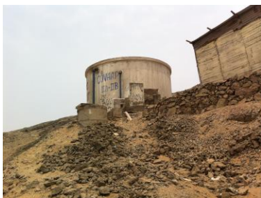
生活域の上水道タンクは住民組合で管理。1日2時間ほどしか水道は使えない
