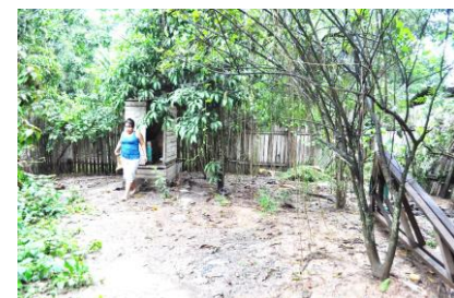
いわゆる素掘式トイレ、おがくず投入で腐臭を中和。満杯になると場所を変える。
