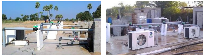
大型浄化設備
