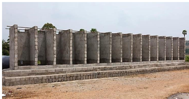
集合トイレの設置工事現場
