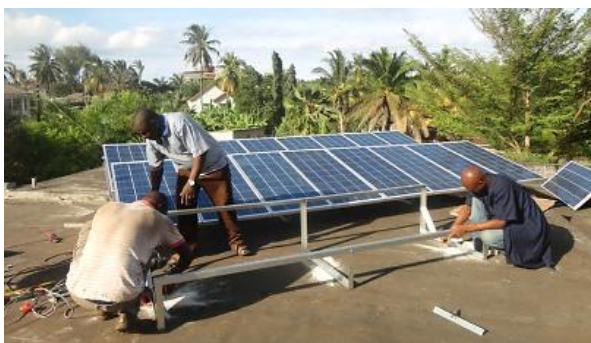
一般家庭へのソーラーパネル設置作業
