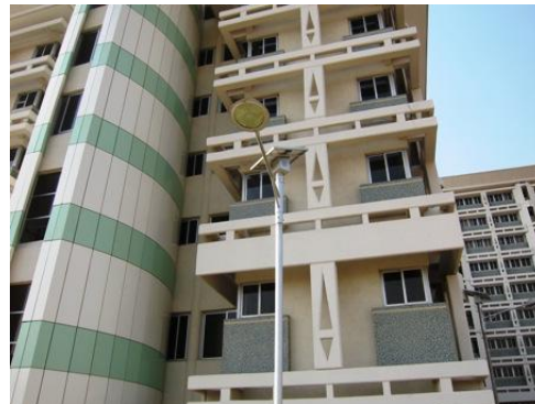
建設中の外務省の街灯もソーラーパネル式
