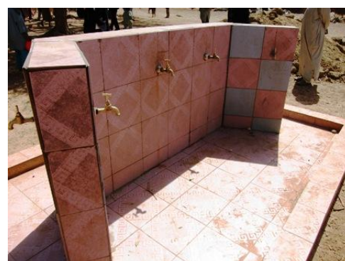
水道部分。蛇口をひねるノブの部分は取り外しできるようになっており、ノブの管理をすることで、水の利用を制限できるようになっている。
