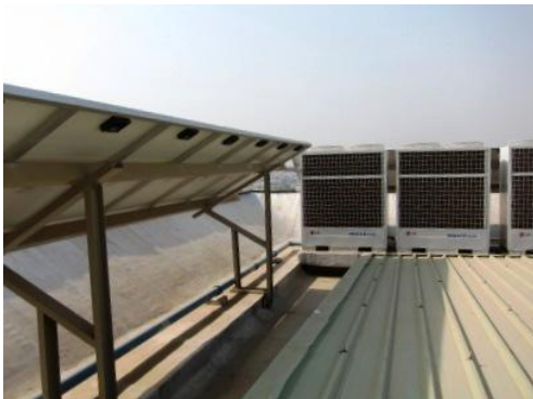
ケーブル類が未だ接続されていないが、仕組みは非常に簡素なものであることが窺える(正面奥の装置は韓国LG製のエアコン室外機)。
