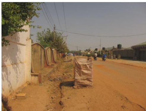
排水溝が乾季の砂で埋もれてしまい、浅くなっている。雨季にはここから排水が溢れ出す。(カドゥナ郊外)
