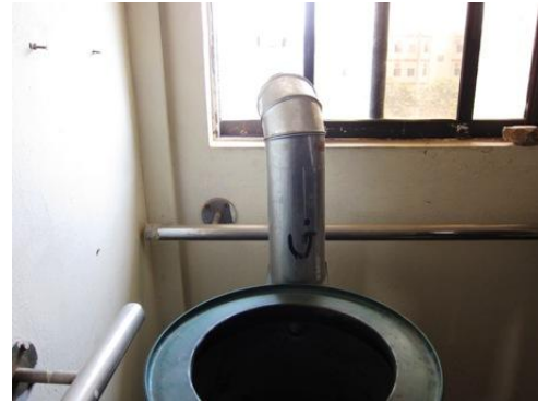
薪から出る煙は、直接窓から逃がす。
