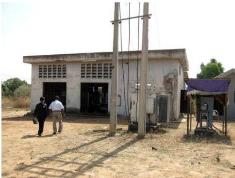
自家発電専用の建屋で、2機の大型発電機が稼働している。
