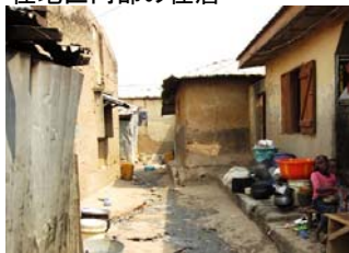
アブジャ都市部 トタンもはがれかけ、路地の路面状況も良くない
