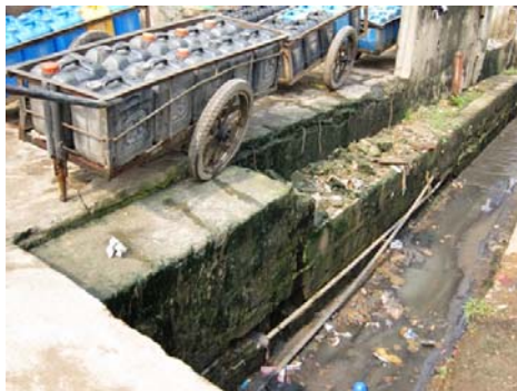
ラゴス都市部 BOP 居住区の給水所前の側溝
