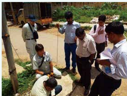
漏水調査現場
