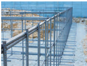
住宅基礎用ユニット鉄筋
