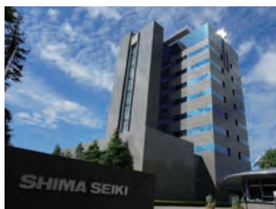
本社ビル外観
