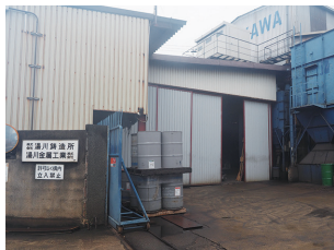
和歌山工場外観
