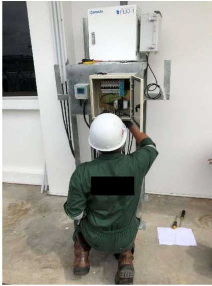
写真 5-1. 分電盤取付作業
