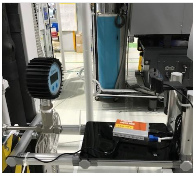
図 6-1 Daiwa Kasei 実証実験対象
