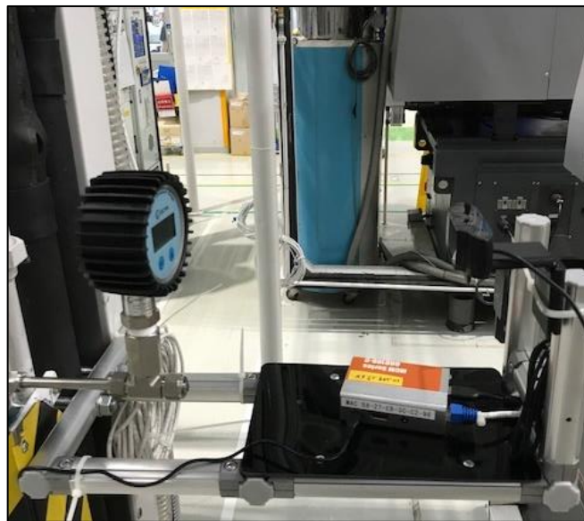
図 5-21 Daiwa Kasei 実証実験対象
