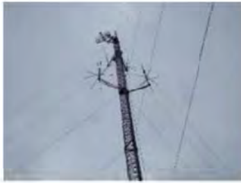
中継器2 (現地オフィス) 設置作業
