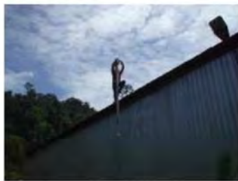
受信器1 (Power House) 設置作業
