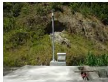
取水口 発信器1 建柱作業 バッテリーボックス取付
