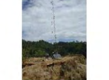
中継器1 取付作業
