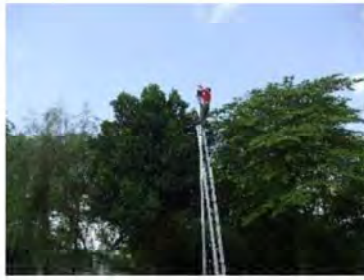
CCTV&無線機(送信機)
