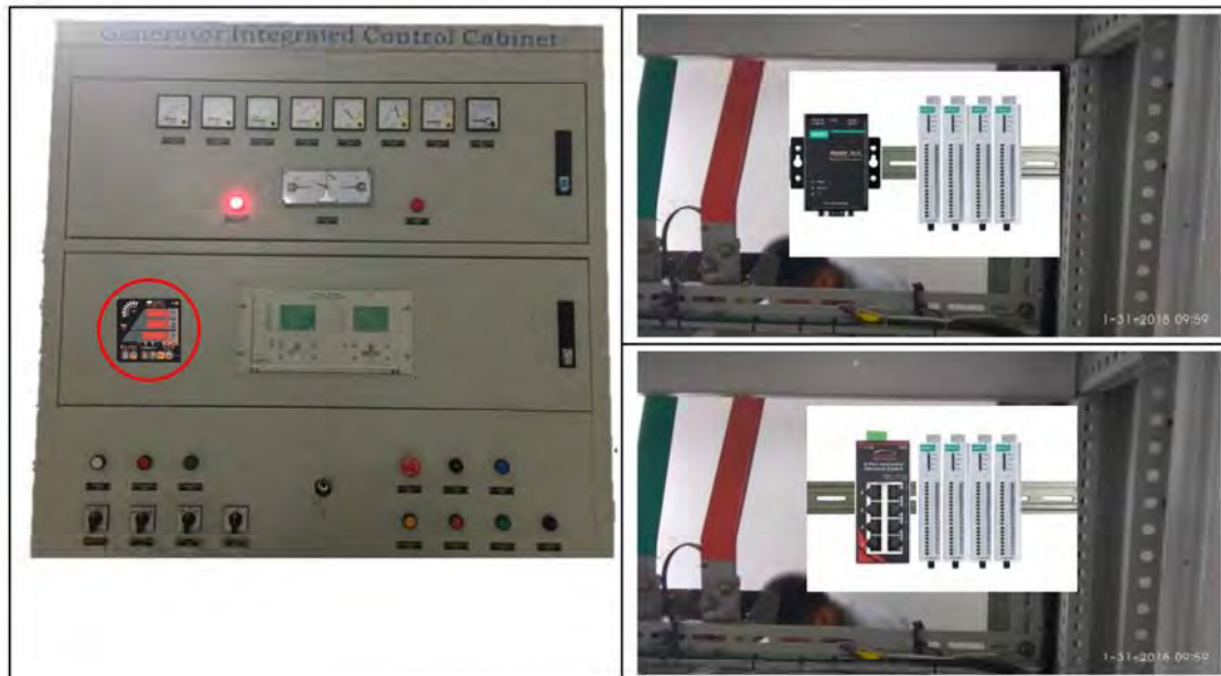
図 6-21 MFM と ioLogik E1200 Serie の取り付け場所
