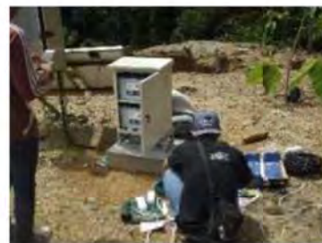
中継器1 (Sand Pond) バッテリーボックス取付作業
