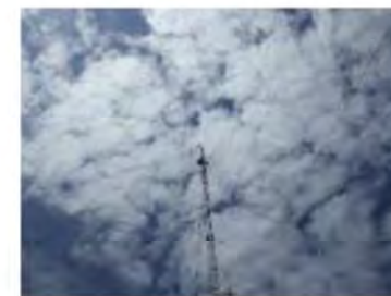
中継器1 設置作業 (35M 鉄塔に取付)
