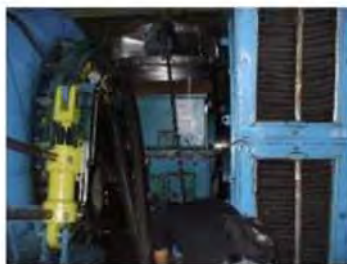
振動センサー 取付 (Generator No.1)
