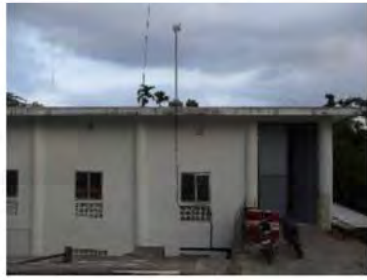
パワーハウス屋上の受信機
