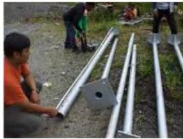
鋼管柱 寸法確認
