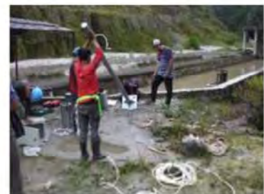
発信器2 (Sand Pond) 建柱作業
