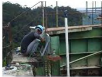
発信器3 バッテリー架台 取付作業
