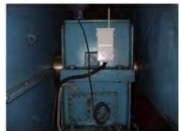
振動センサー 取付 (Generator No.1)
