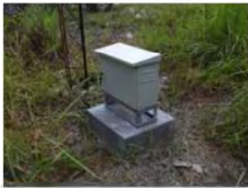
中継器3 (Head Pond) バッテリーボックス
