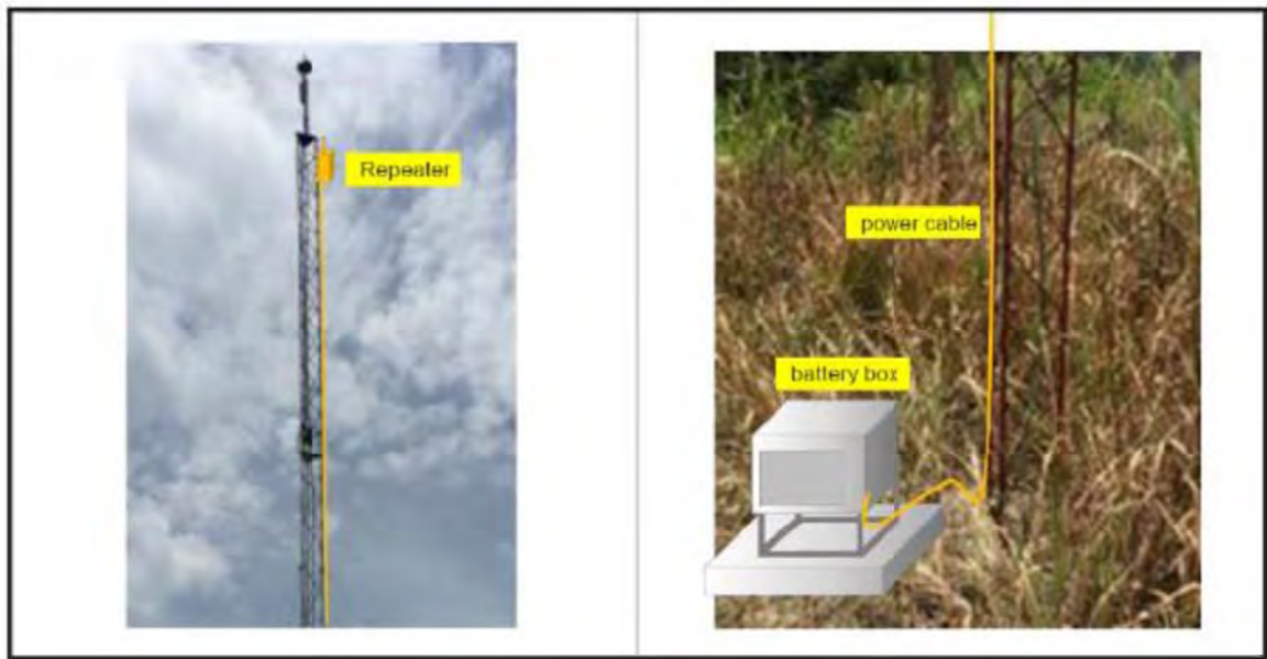
図 4-14 ヘッドポンド近辺の既設タワーに設置する中継機の設置計画図
