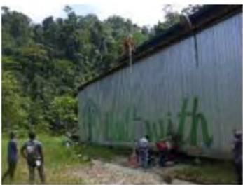
受信器1 (Power House) 設置作業
