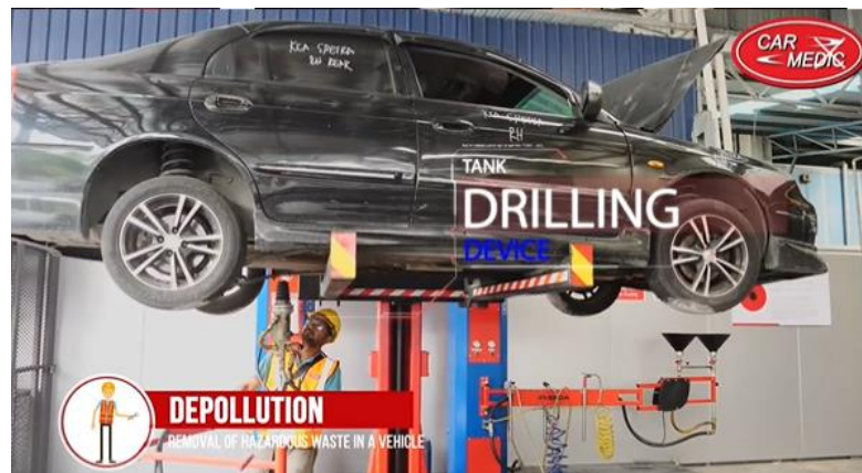
工場内での解体作業の様子
