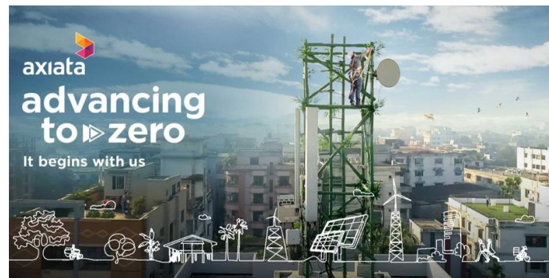
竹を使用して作られた基地局
