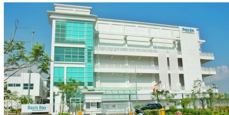
セランゴール州のグリーンデータセンター
