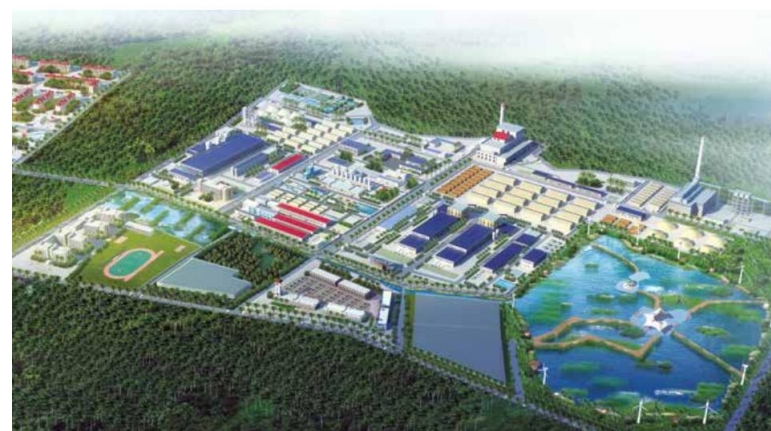
パハン州ペカンに建設中のGTP
