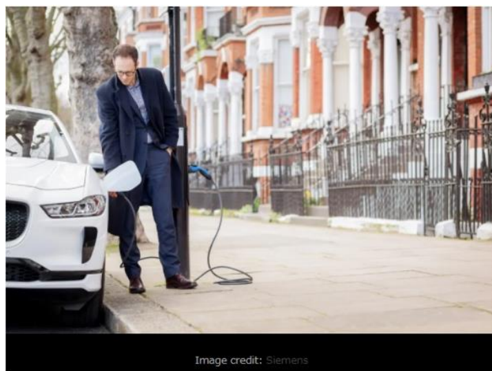
図表 35 : 街灯 EVSE (1)
