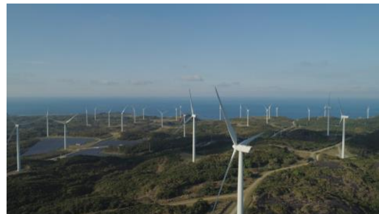
北イロコス州の風力発電所
