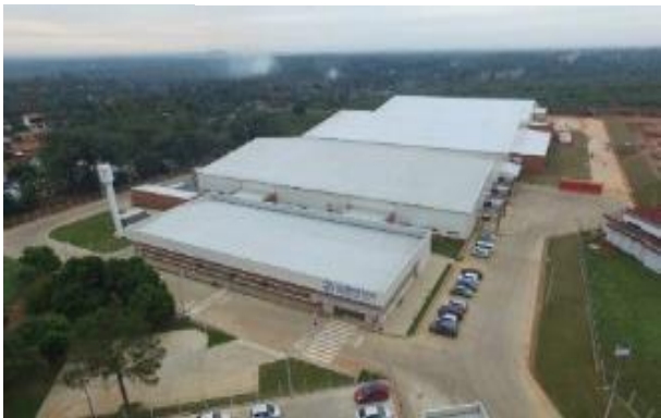
ワイヤーハーネス製造工場
