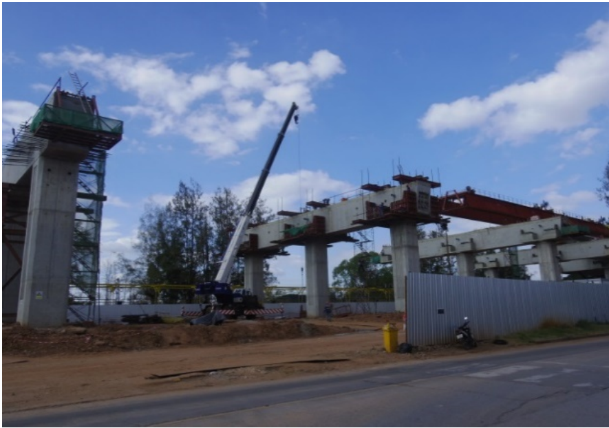
コンケン市内で建設が進む複線化工事(ジェトロ撮影)
