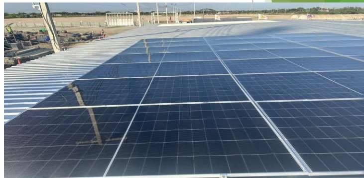
Panel surya terpasang di atap kantor lokasi konstruksi di Thailand
