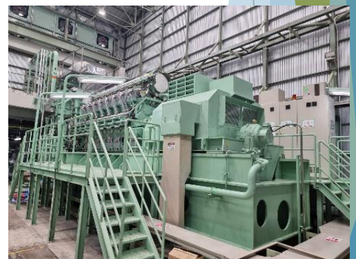
コージェネレーションシステム (タイでの事例)
