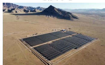
太陽光発電・蓄電池
