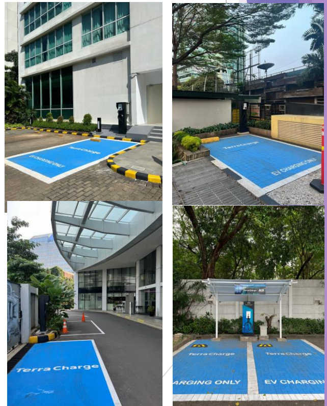
EV充電設備の導入事例
