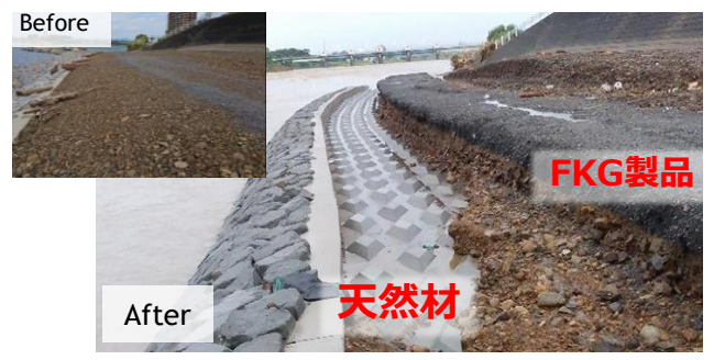
洪水の際にも、流されず道として残り浸食に強い
