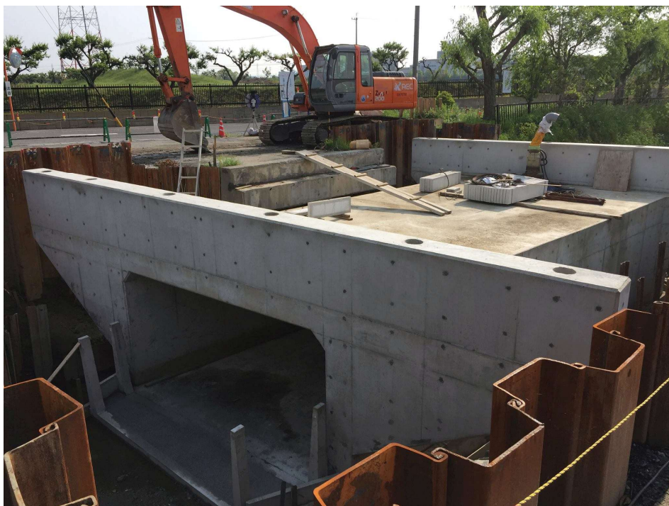
道路整備工事
