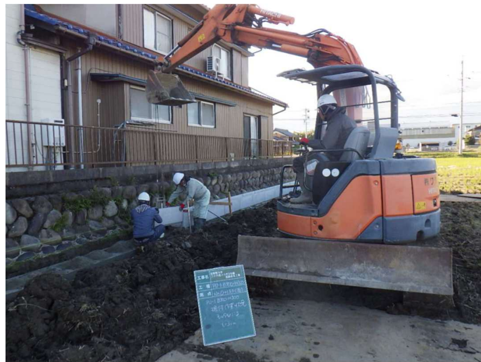
道路改良工事
