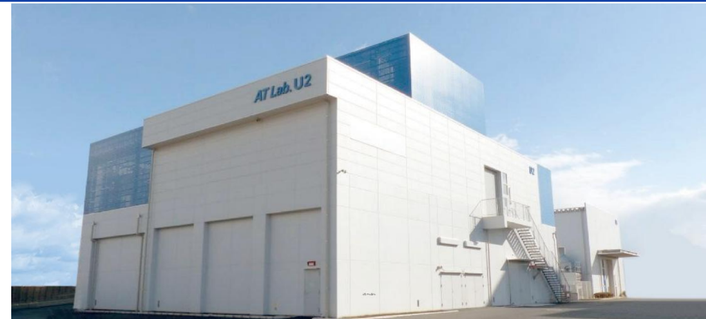
自動車実験棟 Automotive Testing Lab
