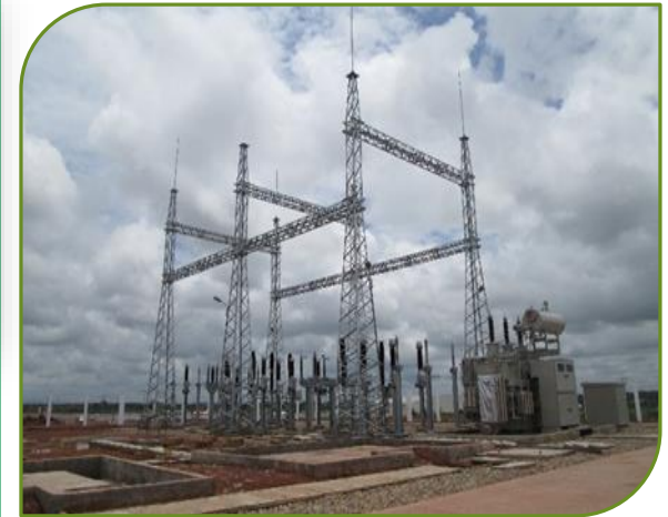
110MVA変圧所 110MVA 第一ステージ 30 MVA
