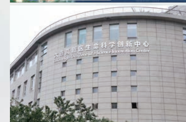
インキュベーター——生命科学イノベーションセンター 面積：1.18 万平方メートル
