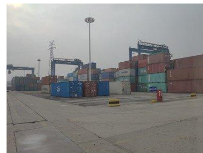
陽邏港の コンテナヤード
