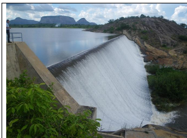
写真1：Monapo ダム：雨季はダム許容能力を超えて水が溢れている状況
