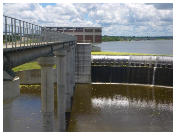
写真 2 : 取水堰（予定）と送水管の一部
