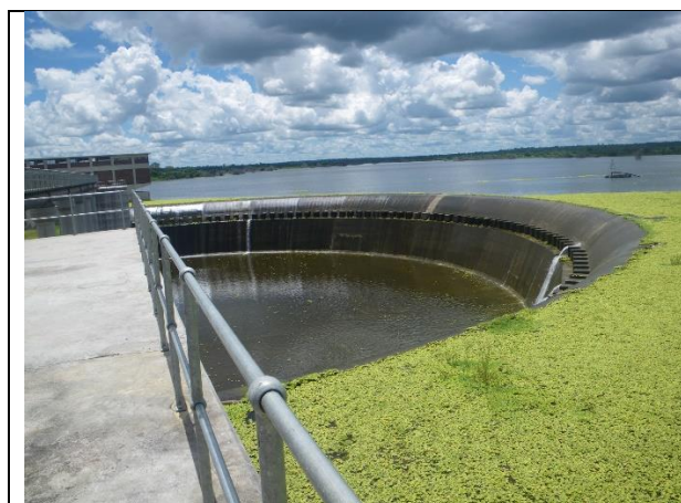
写真 1 : MCA 支援で完成したナカラダム
