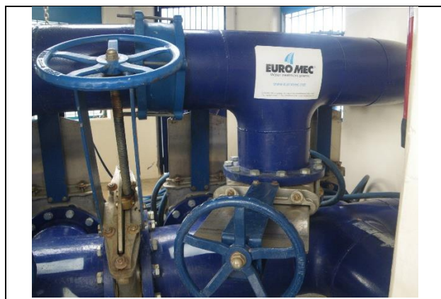
写真3：取水堰内のポンプ - EuroMec 社
