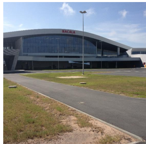
図 2 : ナカラ国際空港のターミナルと誘導路
