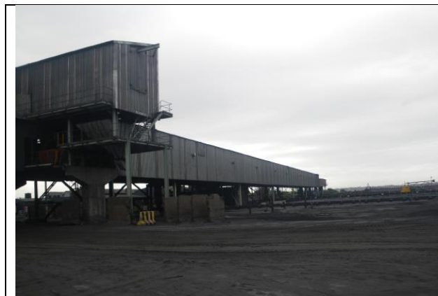
TCM のコンベイヤー施設
