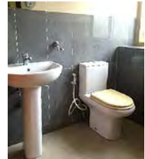
マスタールームの トイレ・浴室
