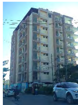
建設中マンション(ムササニ地区)
