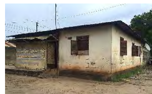
長屋の外観(入口)
