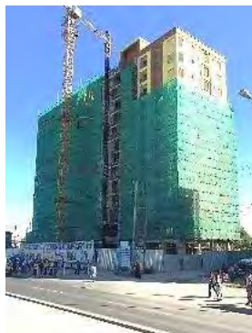
建設中マンション(マンゼセ地区)
