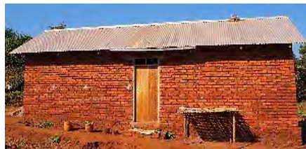
小型のソーラーパネルを屋根に設置している家(モロゴロ州)
