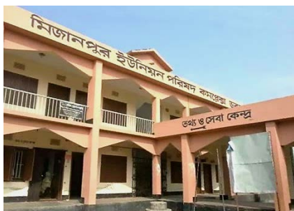
デジタル・センタービル (ラジバリ県Mizanpur行政村)
