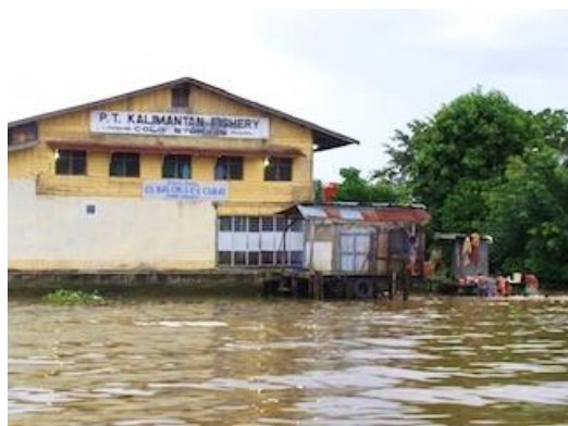
冷蔵設備(南カリマンタン州バンジャルマシ市)
