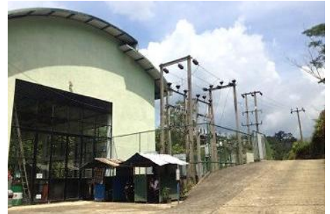
民間投資による小規模水力発電所
