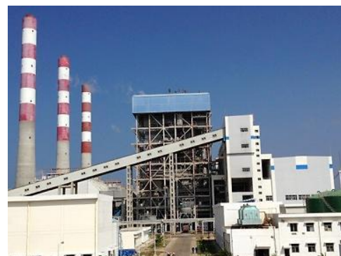
ラクウィジャヤ石炭火力発電所
