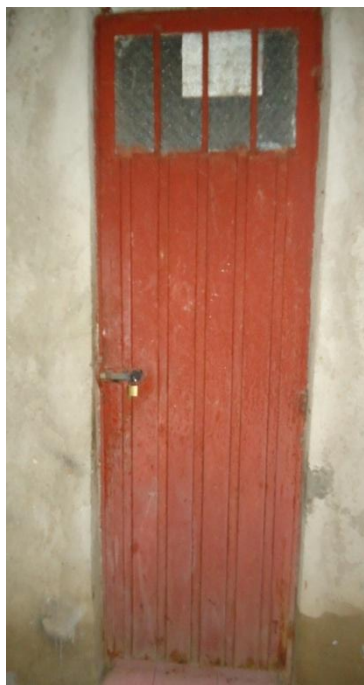
トイレ、浴室の入口
