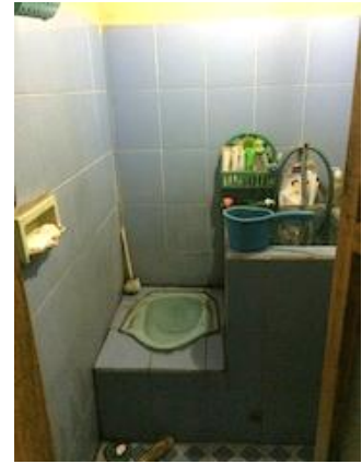
奥の部屋のトイレ兼沐浴場
