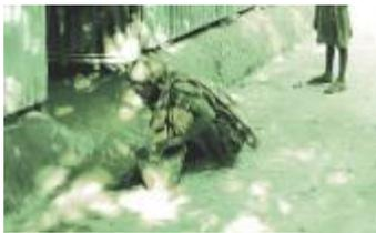
床の補修(泥塗り作業)
