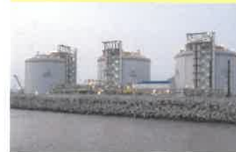
LNG Terminal in Shanghai
