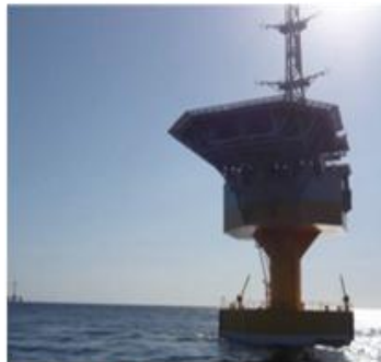
ฐานรองรับลมทะเลแบบลอยน้ำ (เครื่องแปรกระแสไฟ)
