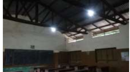
図 18. 太陽光発電システムで灯った教室内の電灯
