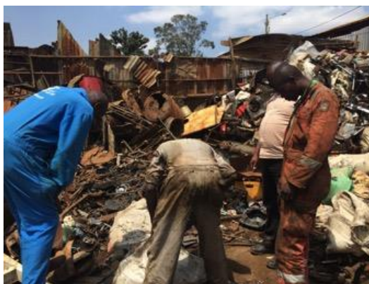
<現地の解体事業者>
