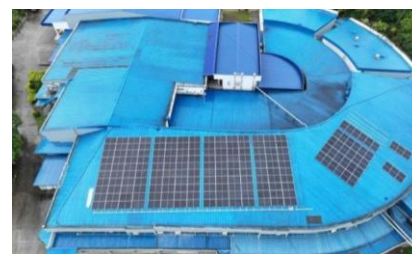
顧客名 : AM-Europharma 設置容量: 115.2 kWp
