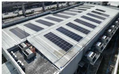
顧客名 : Decathlon 設置容量: 225.06 kWp
