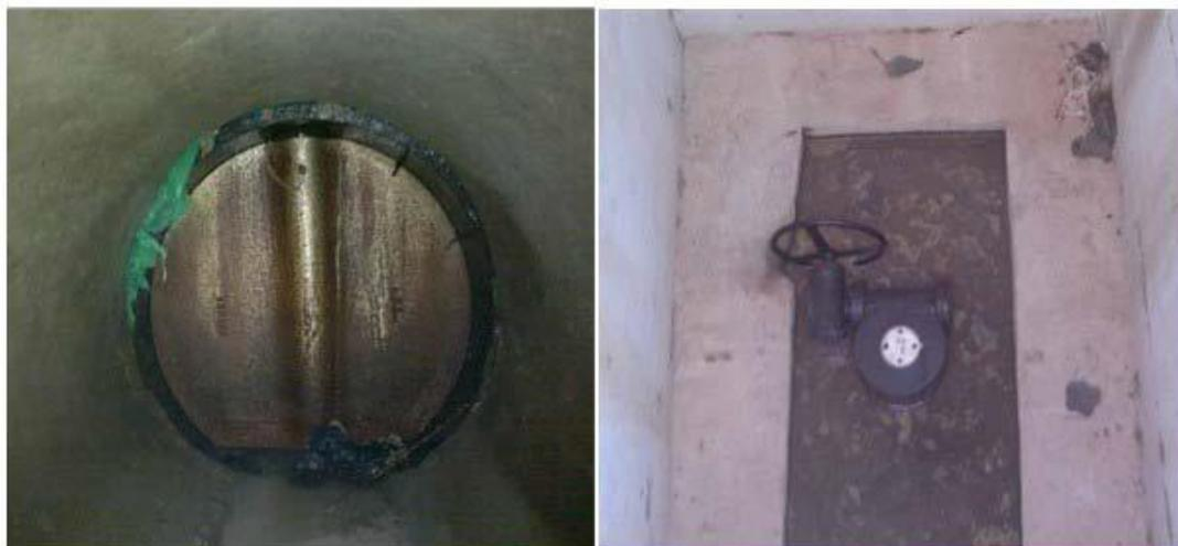
図表 8 雨水口の封印
