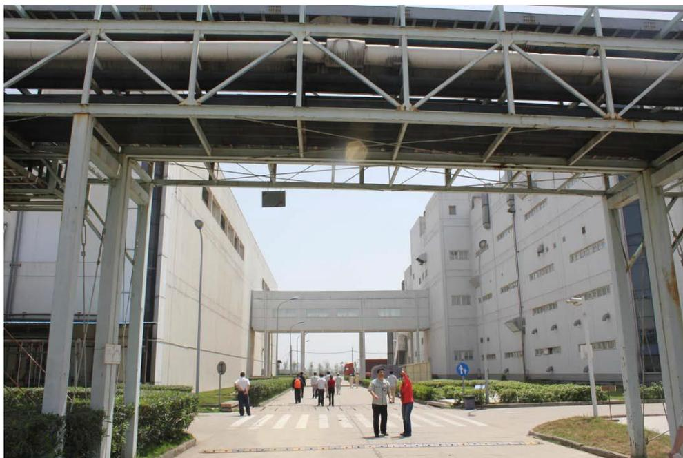
図表 7 廃水と雨水のパイプラインの混在を避けるために、地下の工業廃水輸送配管を地上に移し変えた。
