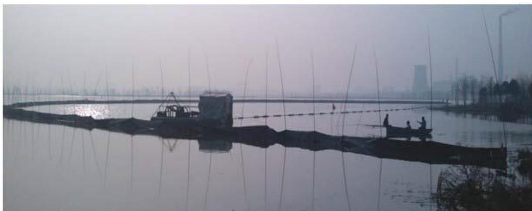
図表 15 南太子湖の浚渫現場写真一簡易浚渫船 1 隻と汚泥引抜ポンプ
