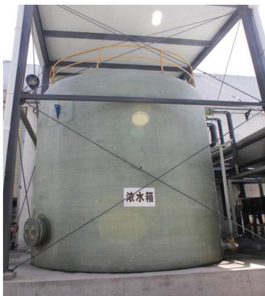
図表10 以前はRO水が雨水系統に排出されていたが、監査時にはRO回收利用系統がすでに完成し、使用されていた。
