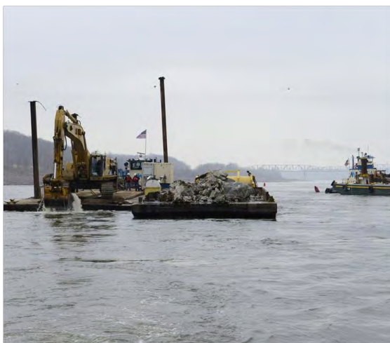
写真：陸軍工兵隊による岩の除去作業。陸軍工兵隊ウェブサイトより。
