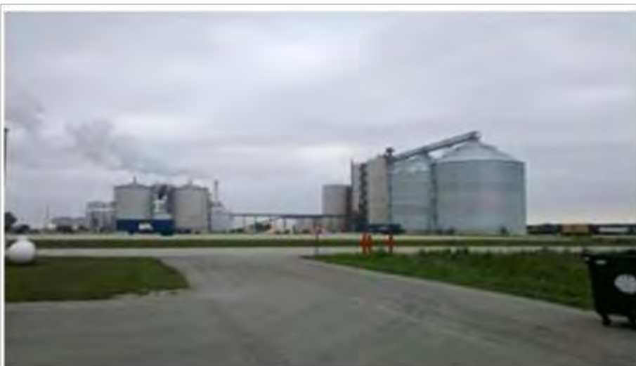
エタノール工場全景
