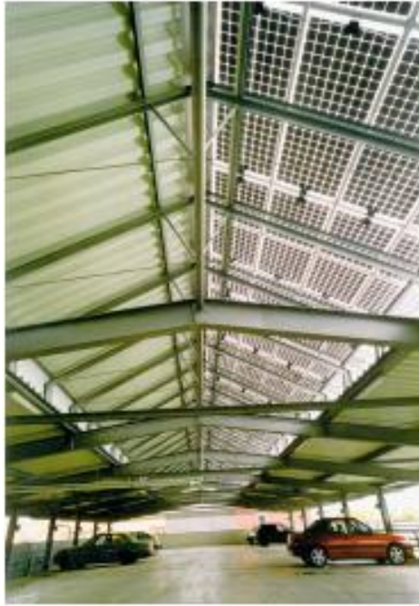
図 32 駐車場の屋根と一体となった太陽光発電パネル
